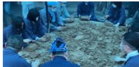
築炉用の粘土を練りブロックを作ります。炉に使用する土は操業の成否を決める重要な役目を果たします。
